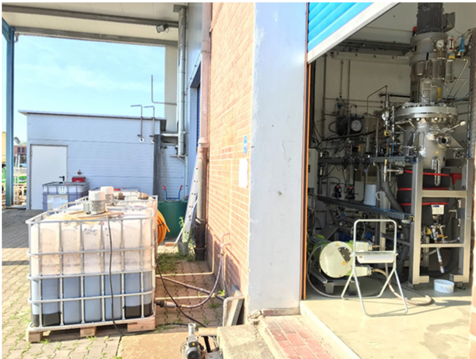
Abbildung 19 - Technikum in Schwandorf mit Klärschlammproben ARA Reinach und Versuchsreaktor
