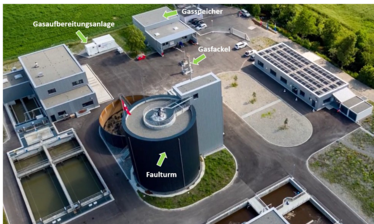
Abbildung 2 - ARA Reinach mit Gasaufbereitungsanlage. Bildquelle: (Müller und Oester 2018)
