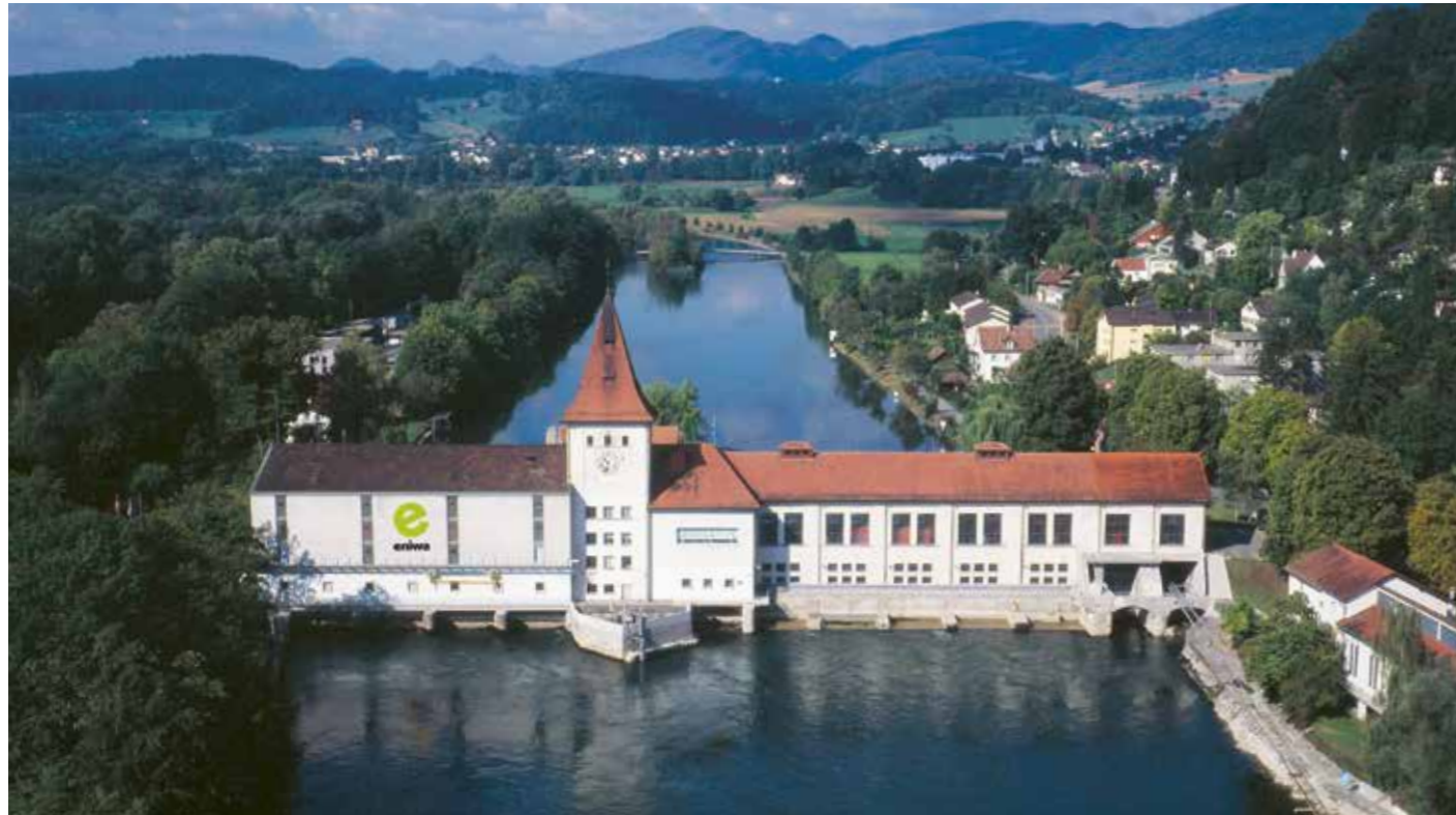
Frontansicht des Eniwa Wasserkraftwerks in Aarau
