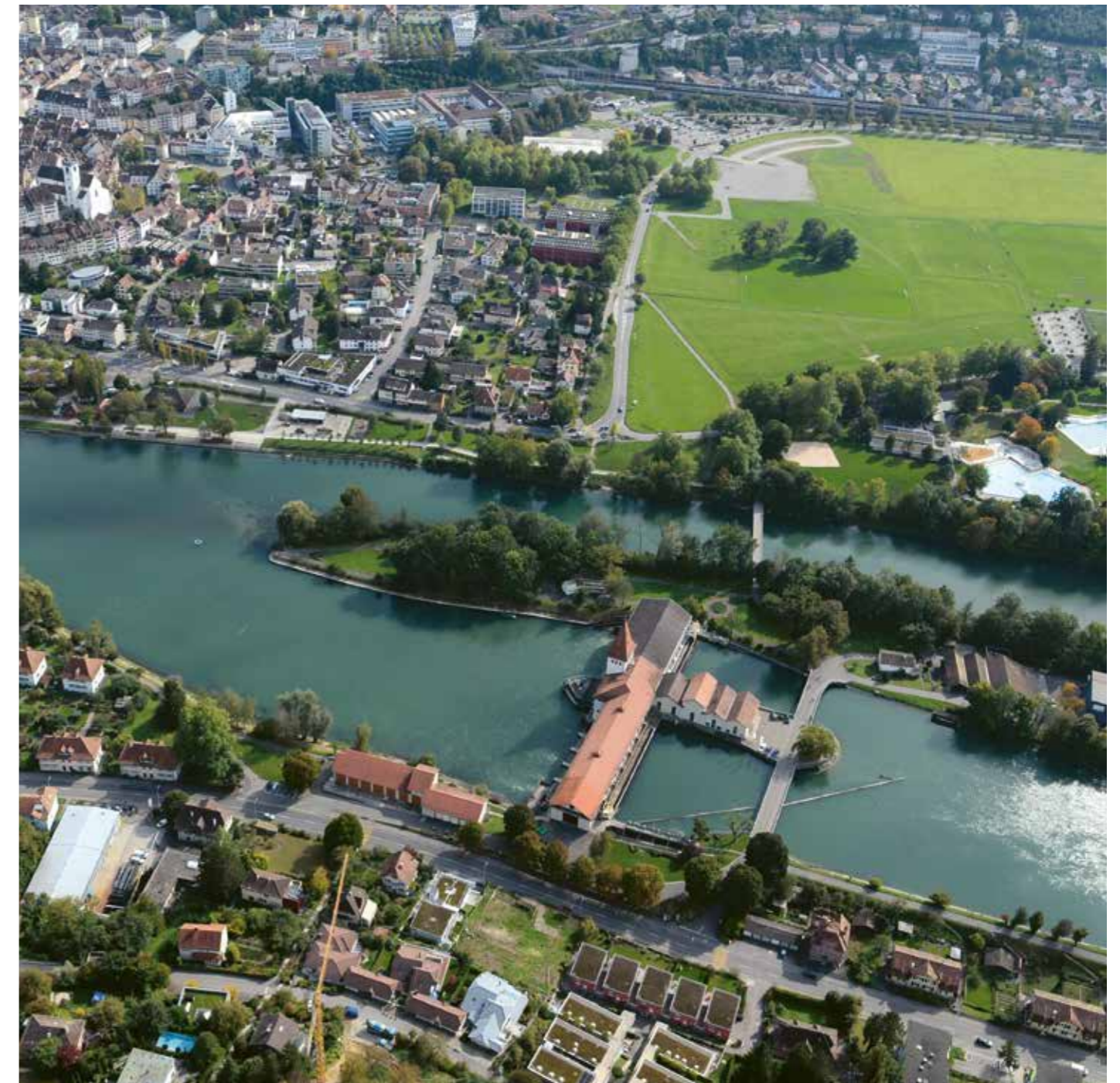
Luftaufnahme des Eniwa Wasserkraftwerks in Aarau
