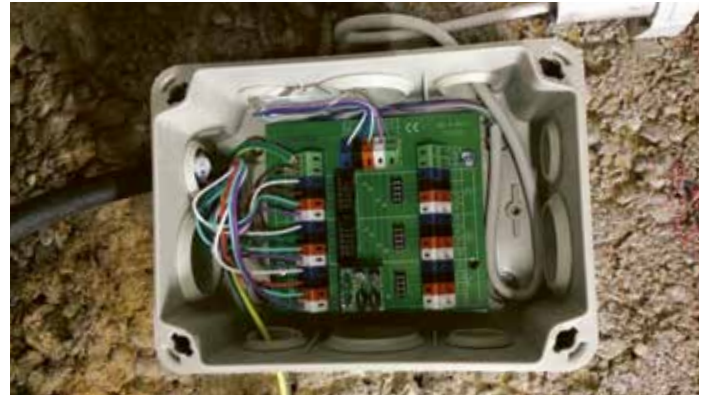
Beispiel eines Bus Kabel-Anchlusses vom Regler auf die Blitzschutzdose. (Die Blitzschutzdose wird durch Eniwa montiert. Die Leitung und das Kabel vom Regler zur Blitzschutzdose wird durch Elektroinstallateur vor Ort installiert.)
